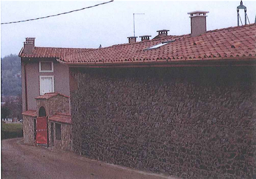
FOTO N.02 – vista su via Monte di Pena – fabbricato "A" e "B"
