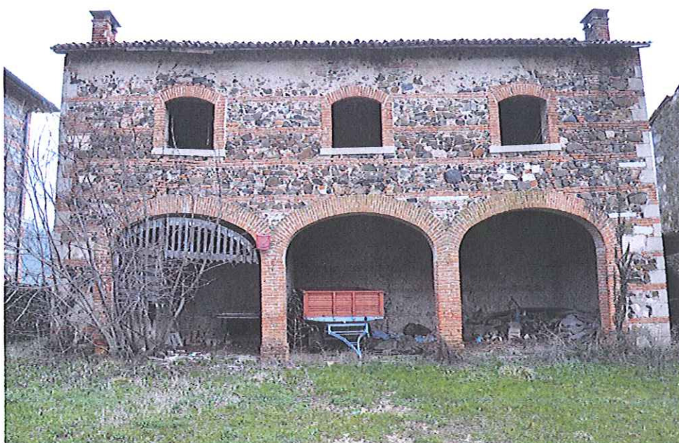
FOTO N.08 – vista corte del fabbricato "C"
