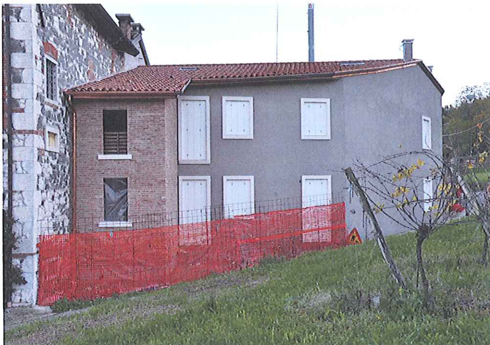
FOTO N. 04 – vista sul retro fabbricato "B"
