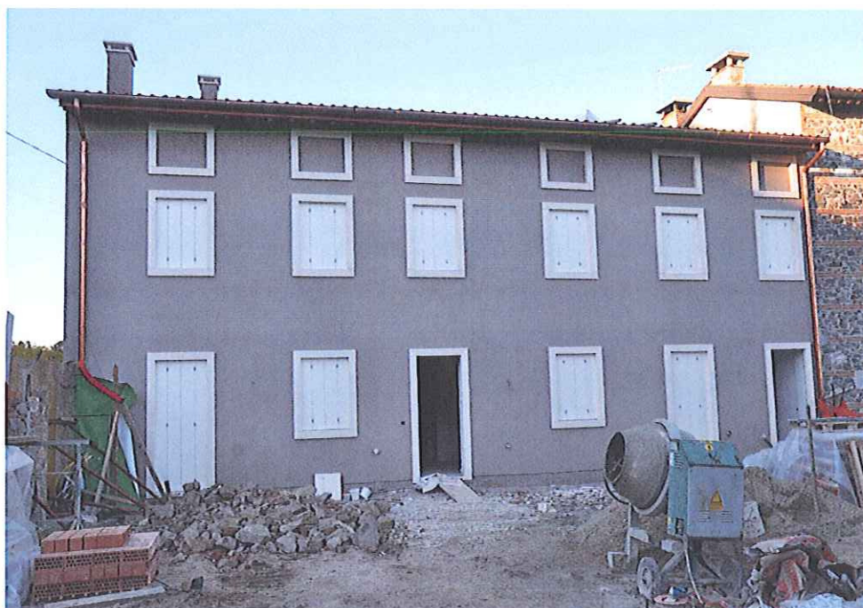
FOTO N. 07 – vista dalla corte – fabbricato "B"
