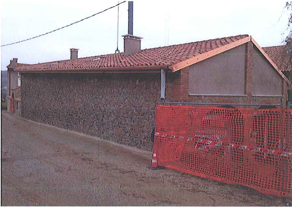
FOTO N.01 - vista su via Monte di Pena – fabbricato "A"
