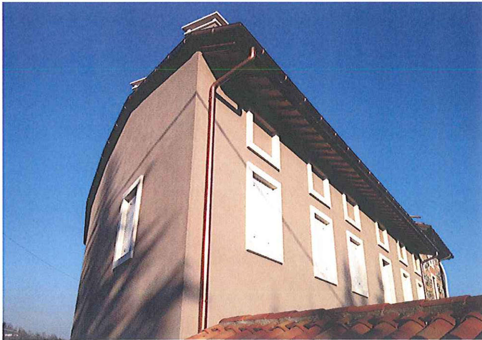
FOTO N. 03 – vista fabbricato "B"
